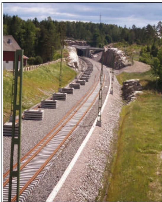
Bygge av dubbelspår mellan Öxnered och Trollhättan.
