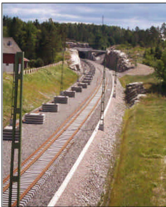
Bygge av dubbelspår mellan Öxnered och Trollhättan.
