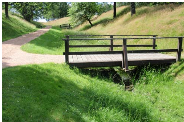
Vid stora nederbördsmängder kan dagvatten avledas i diken.
