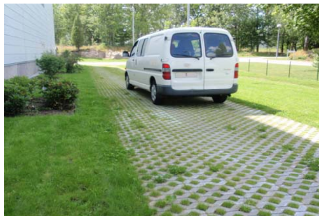
Permeabelt ytskikt främjar infiltrationen jämfört med en hårdgjord yta.
